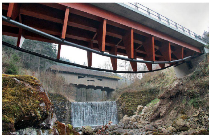
Die denkmalgeschützte Holzbrücke und die neue Brücke von 2012 nehmen mit ihren beiden Bögen Bezug zu einander: Der neue Brückenträger mit Unterspannung ist das statische Spiegelbild des Druckbogens der alten Holzbrücke.
