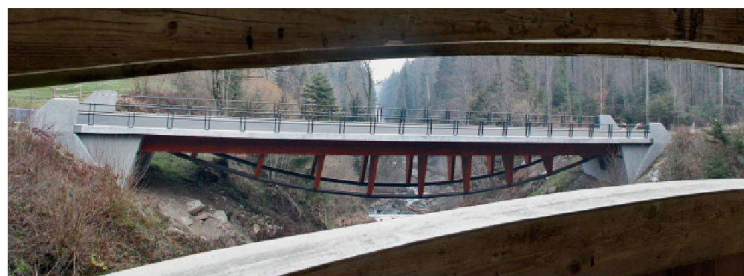
Die Widerlagerbauwerke erscheinen eigenständig, weil sie gestockt und mit einem seitlichen Kragen versehen sind, der sich ausgehend von den Leitmauern dreieckförmig nach unten verjüngt.
