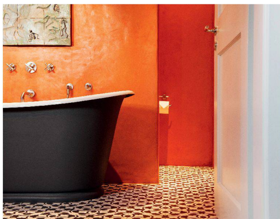
Badezimmer mit Wand aus Tadelakt, Privathaus in Küsnacht ZH, Umbau 2008/2009. Architektur: Greco+Kubli, Küsnacht.
