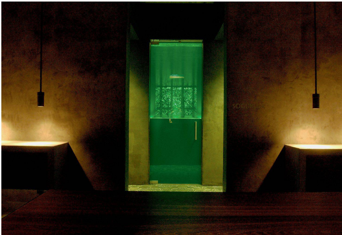
Hamam der Migros im ehemaligen Trafogebäude der ABB in Baden AG, 2007. Es wurden ca. 1000 m 2 Wand mit Terra di Pietra in Grau- und Anthrazittönen sowie Lichtgrün als Kontrast verputzt. Innenarchitektur: Ushi Tamborriello, Baden.
