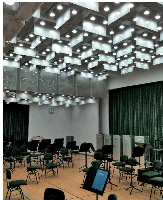
Erste Ausführung 2007 des Schalldiffraktors an der Decke in einem Probesaal des «Teatre del Liceu» in Barcelona.
