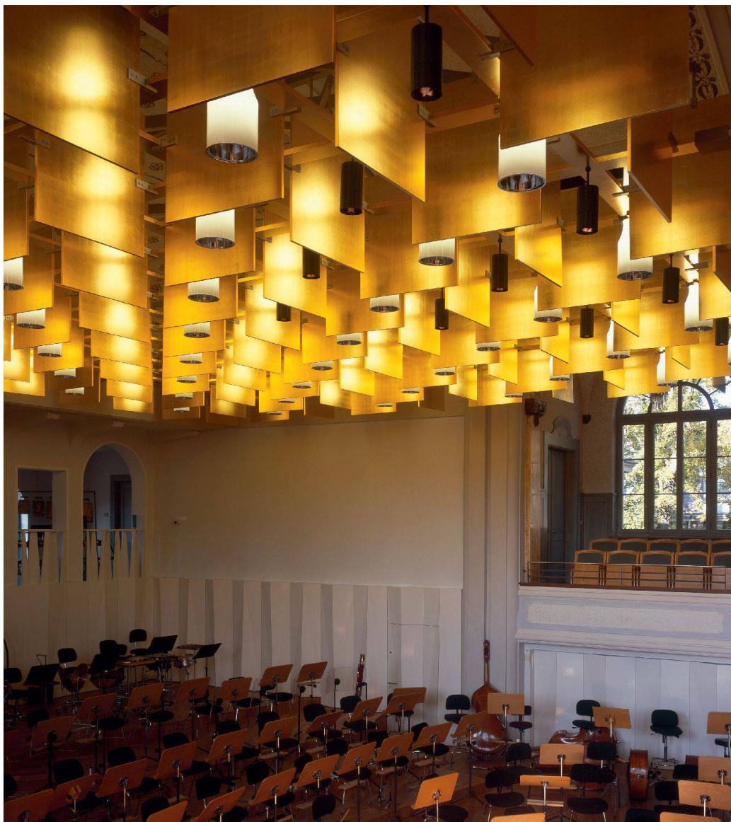
Bühnenbereich der Tonhalle St. Gallen mit dem unter der Decke aufgehängten Schalldiffraktor. Hinter der Bühne sind die schalldiffundierende weisse Holzverkleidung und die Holzbalustrade der Empore mit dem gleichen Zweck erkennbar. Die Bühne ist für ein Orchester mit sehr grosser Besetzung bestuhlt.
