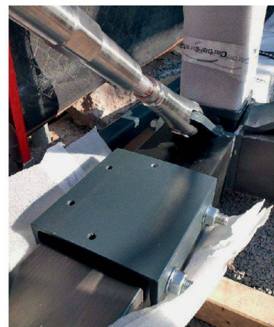
Anschlussdetail der Carbonträger.
