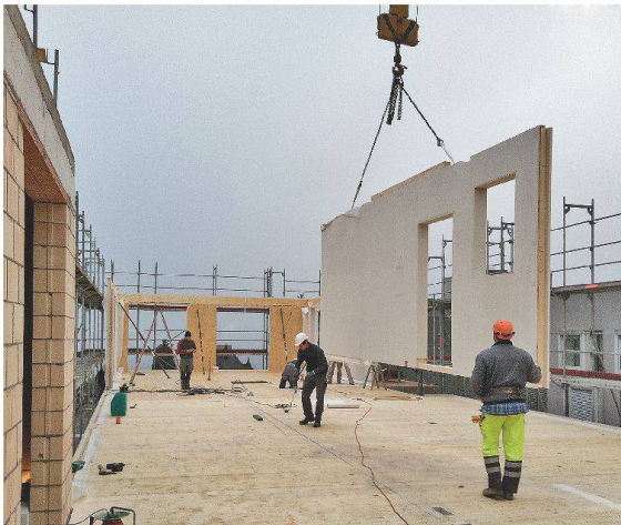
Montage der Wandelemente und der Hohlkastendecken. Wegen der kaum vorhandenen Baustellenfläche und der kurzen Bauzeit wurde der Elementbauweise der Vorzug gegeben. Bereits nach einer Woche waren der Holzrohbau aufgestellt und das Dach abgedichtet.
