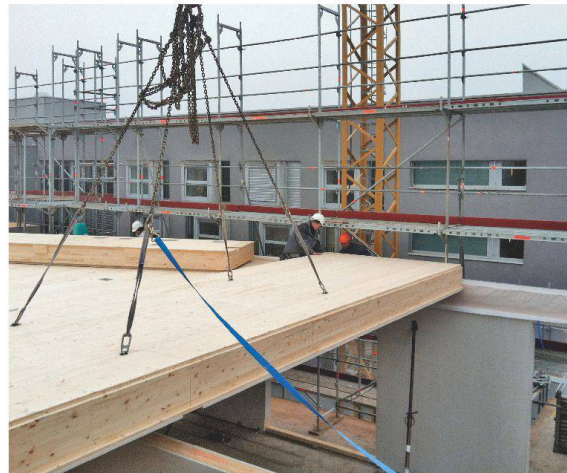
Montage der Wandelemente und der Hohlkastendecken. Wegen der kaum vorhandenen Baustellenfläche und der kurzen Bauzeit wurde der Elementbauweise der Vorzug gegeben. Bereits nach einer Woche waren der Holzrohbau aufgestellt und das Dach abgedichtet.
