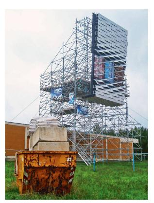
1:1-Modell der Fassade. Die Wölbung der Aluminiumbänder variiert und reguliert die Dichte der Fassade.
