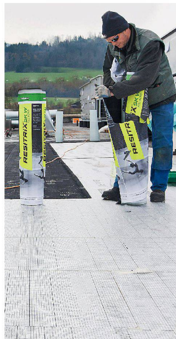
Resitrix von Resiswiss beim neuen Ricola-Produktionsgebäude in Laufen.
