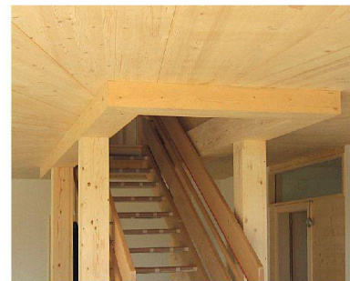
Geschossdecke mit GFP von Schilliger.
