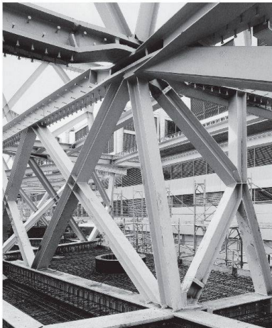
Baustellenaufnahme eines Fachwerkknotens des Actelion Business Center, Allschwil BL.
