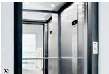
Der «Magic» von AS (Abb. 02) ist ein Lift mit spezifischen Vorteilen. Mit einer Schachtkopfhöhe von lediglich 2.4 m nimmt er rund einen Meter weniger Platz in Anspruch als herkömmliche Aufzüge. Daher lässt sich mit dem «Magic» ohne zusätzlichen Dachaufbau problemlos die oberste Etage von Gebäuden erschliessen. Der Lift lässt sich unter einer durchgezogenen Betondecke und
