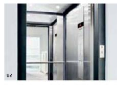
Der «Magic» von AS (Abb. 02) ist ein Lift mit spezifischen Vorzügen. Mit einer Schachtkopfhöhe von lediglich 2.4 m nimmt er rund einen Meter weniger Platz in Anspruch als herkömmliche Aufzüge. Daher lässt sich mit dem «Magic» ohne zusätzlichen Dachaufbau problemlos die oberste Etage von Gebäuden erschliessen. Der Lift lässt sich unter einer durchgezogenen Betondecke und
