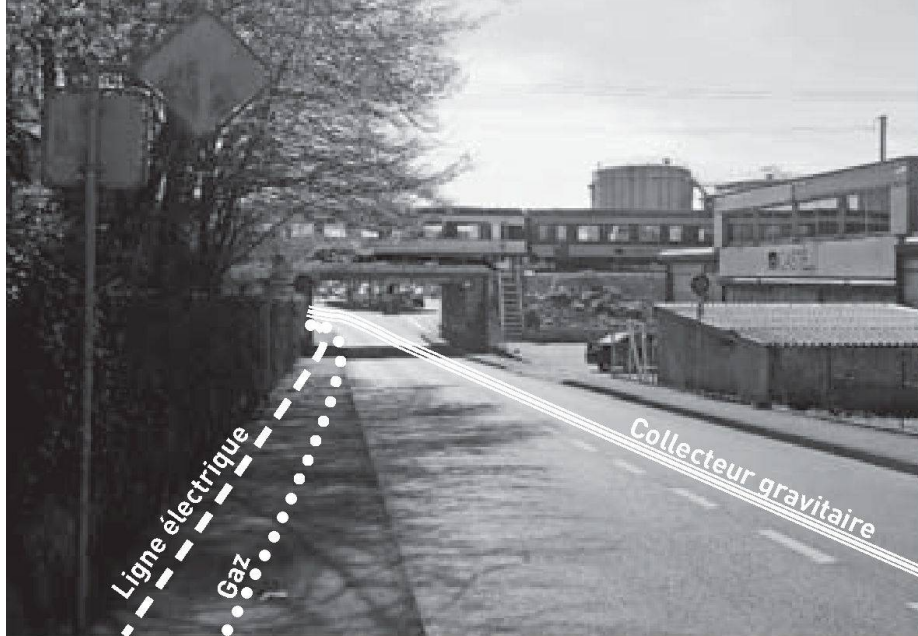
01 Photo de l'ouvrage côté nord et SIG.
