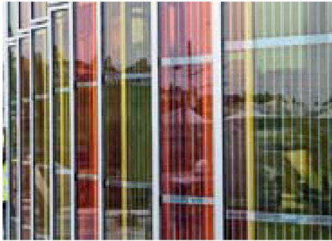
Die Graetzel-Solarzellen wurden an der EPFL erfunden. Im Swiss Tech Convention Center kommen sie erstmals auf einer grossen Fläche zur Anwendung. (Foto: Roman Herzog)
