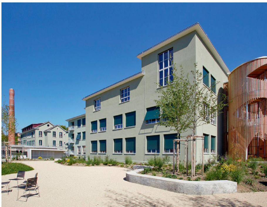
01 1972 wurde der Betrieb der Forsanose-Fabrik eingestellt. Nach rund 40 Jahren Leerstand konnten im März 2013 die ersten Wohnungen bezogen werden. (Fotos: Heinz Unger)
