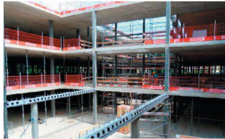
Deltabeam-Stahlprofile von Peikko im Einsatz.
