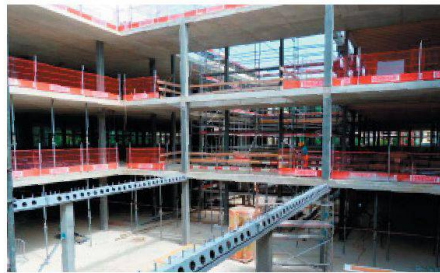
Deltabeam-Stahlprofile von Peikko im Einsatz.
