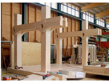
02 «Knopfloch» in einem Träger vor Einbau der Hartholzeinlage.
