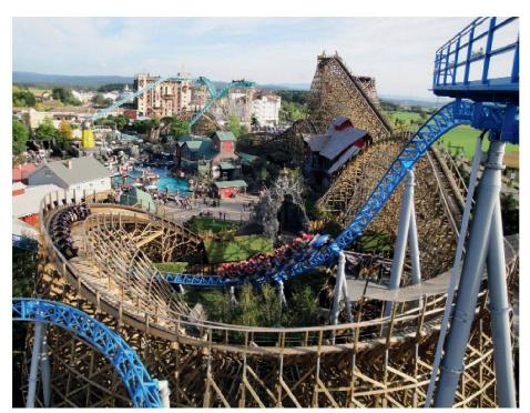
01 Die Holzachterbahn kreuzt zwei Achterbahnen aus Stahl. Bei dieser Enge sind besonders die möglichen Verformungen zu berücksichtigen, da sich Anlagen aus Holz mehrdimensional stärker verformen können als solche aus Stahl. (Fotos: Europa-Park)
