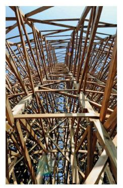
02 Die Tragstruktur ist so konstruiert, dass rund 50 % der Hölzer entfernt werden könnten. Jedes der mit Bolzen verbundenen Elemente kann ersetzt werden.
