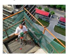
Die beiden Techniker der HMQ AG dokumentierten in Form von CAD-Daten alle Punkte, mit denen nun Krapf die komplette Gebäudehülle plant. Und sie erstellten ein millimetergenaues Fixpunktnetz über die ganze Baustelle. Dieses Netz ermöglicht die aktuellen Gebäudeaufnahmen, aber auch spätere Aufnahmen und Absteckungen mit höchster Präzision. So können bei Montagebeginn die Bezugsachsen und Bezugspunkte für die Montageequipe der Krapf AG mittels Metallplaketten markiert werden.
