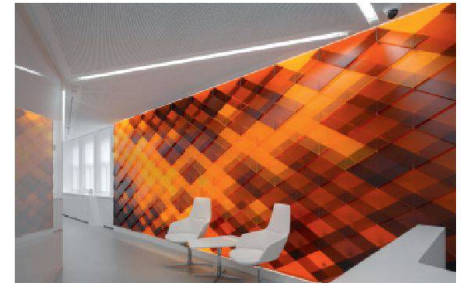
Raiffeisenbank Schaffhausen: Durch Überlappungen der farbigen Glasschindeln entsteht ein Kaleidospokeffekt. (Foto: Roger Frei)
