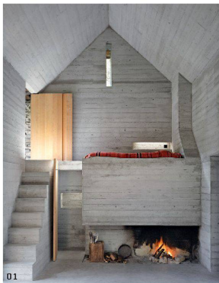
01 Mit zwei Eingängen haben Buchner Bründler aus Basel die Jury überzeugt: Das 200-jährige Gebäude in Linescio TI wurde zunächst ausgehöhlt und dann mit einem Futteral aus Beton versehen. In der steinernen Auskleidung der «Casa d'Estate» sind Elemente wie die Feuerstelle, Badewanne und Schlafnische ausgespart.
