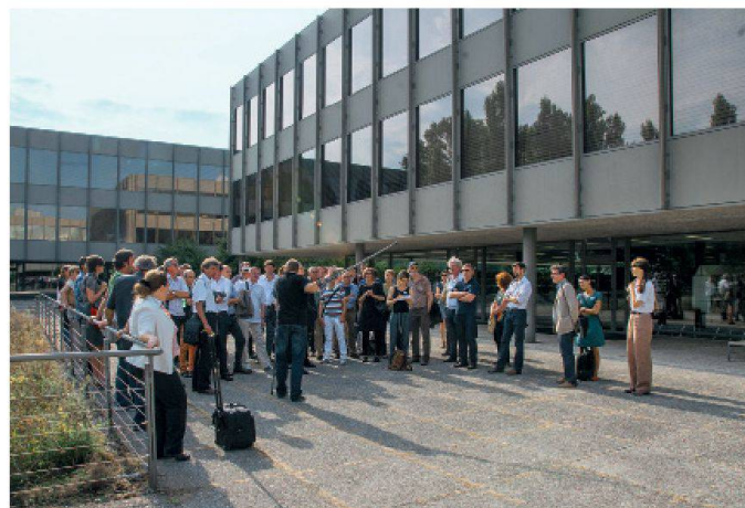
02 Gymnasium Strandboden Biel: Um öffentbare Fenster zu ermöglichen, soll die Originalfassade ersetzt werden. (Foto: Enrique Muñoz García)
