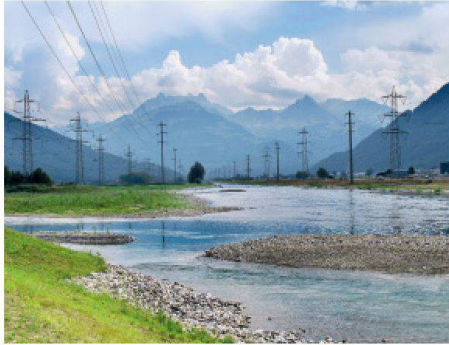
Sanierung des Linthkanals 1998–2013: neue Flussauf- weitung im Hänggelgiessen. In der Flucht des Kanals die markante Silhouette des Mürtschenstocks (2441 m ü. M.). (Foto: cr)
