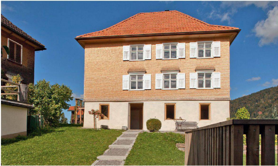
02 Die Südfassade mit der geschlossenen Fensterachse. (Fotos: Christian Grass)
