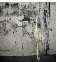
Risse, Rostfahnen, Abplatzungen etc. (Abb. 02–03). Damit können Schäden zu einem relativ frühen Zeitpunkt erkannt werden, was das Ausmass der erforderlichen Instandsetzungsmassnahmen entsprechend reduziert.
