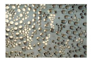
«Die perforierte Wand»<sup>1</sup>: Roboterhergestellte Perforationen bildeten die Grundlage für die Herstellung geometrisch differenzierter Betonelemente. (Foto: Gramazio & Kohler, ETH Zürich)
