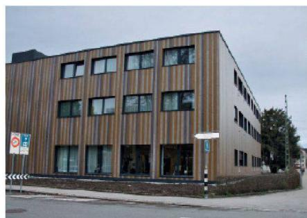
Für das Altersheim Adlergarten in Winterthur realisierte die DM Bau AG im vergangenen Jahr ein Bauprojekt, das die Vorteile des Hybrid-Modulbaus exemplarisch zeigt: Nach fünfmonatiger Bauzeit war das aus 215 Modulen bestehende, dreistöckige Gebäude mit einer Nutzfläche von 4000 m<sup>2</sup> schlüsselfertig und damit zum Bezug bereit. Der temporäre Bau bietet 150 Bewohnern Platz. Eine
