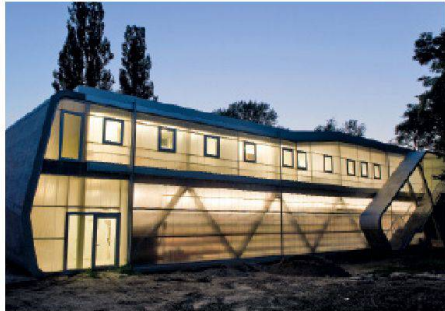
01 Die Betonwandung legt sich wie ein Band um das Gebäude. (Foto: Kai Bienert)
