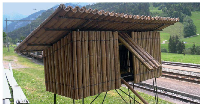
03 Ein Hühnerstall aus Bambus, aufgestellt beim Bahnhof Rossinière, zeigt im Kleinen die Konstruktionsweise mit Bambus. (Fotos: Charles von Büren)
