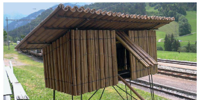
03 Ein Hühnerstall aus Bambus, aufgestellt beim Bahnhof Rossinière, zeigt im Kleinen die Konstruktionsweise mit Bambus. (Fotos: Charles von Büren)
