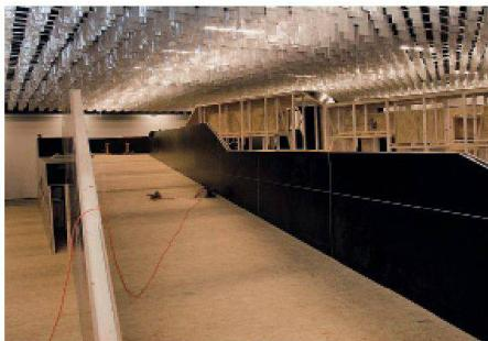
ist so ausgelegt, dass sie statische Belastungen von bis zu 400 kg/m<sup>2</sup> verkraftet. Die Holzverbindungen wurden zugunsten des zeitnahen Rückbaus so einfach wie möglich gehalten. Die Unterkonstruktion aus Konstruktionsvollholz (KVH/BSH) stammt aus heimischen Wäldern (Schweiz, Deutschland oder Österreich). Sie hat einen Umfang von
