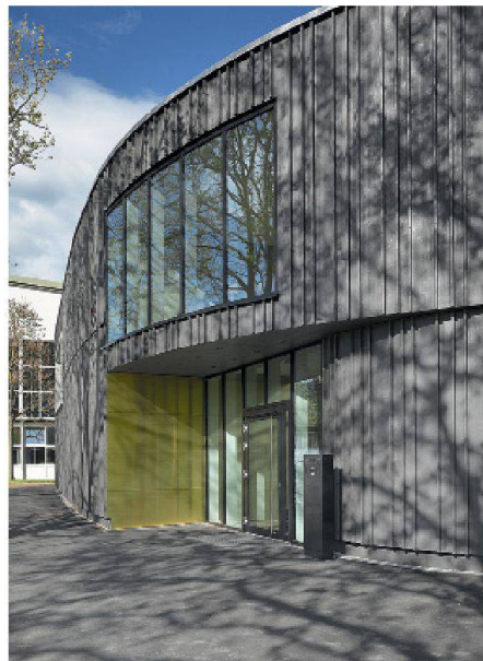
02 Aussenansicht des neuen Ensemblehauses. (Fotos: Roland Halbe)
