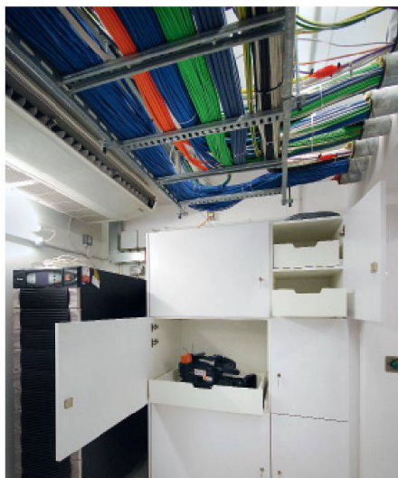
07 Speziell angefertigte Kameraschränke bieten Raum zur sicheren Aufbewahrung des sensiblen Equipments.
