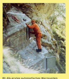
der Schweiz installierte die Bern-Lötschberg-Simplon-Bahn (BLS) 1937 diese Lawinenmeldeanlage im Mahnkinngraben zwischen den Stationen Ausserberg und Hohtenn westlich von Visp VS. Die zwei übereinander angeordneten Klappen ragen in einem Winkel von 45° in den Graben hinaus und werden durch eine Lawine geschlossen, wodurch die Signale entlang der Strecke auf Rot geschaltet werden.
