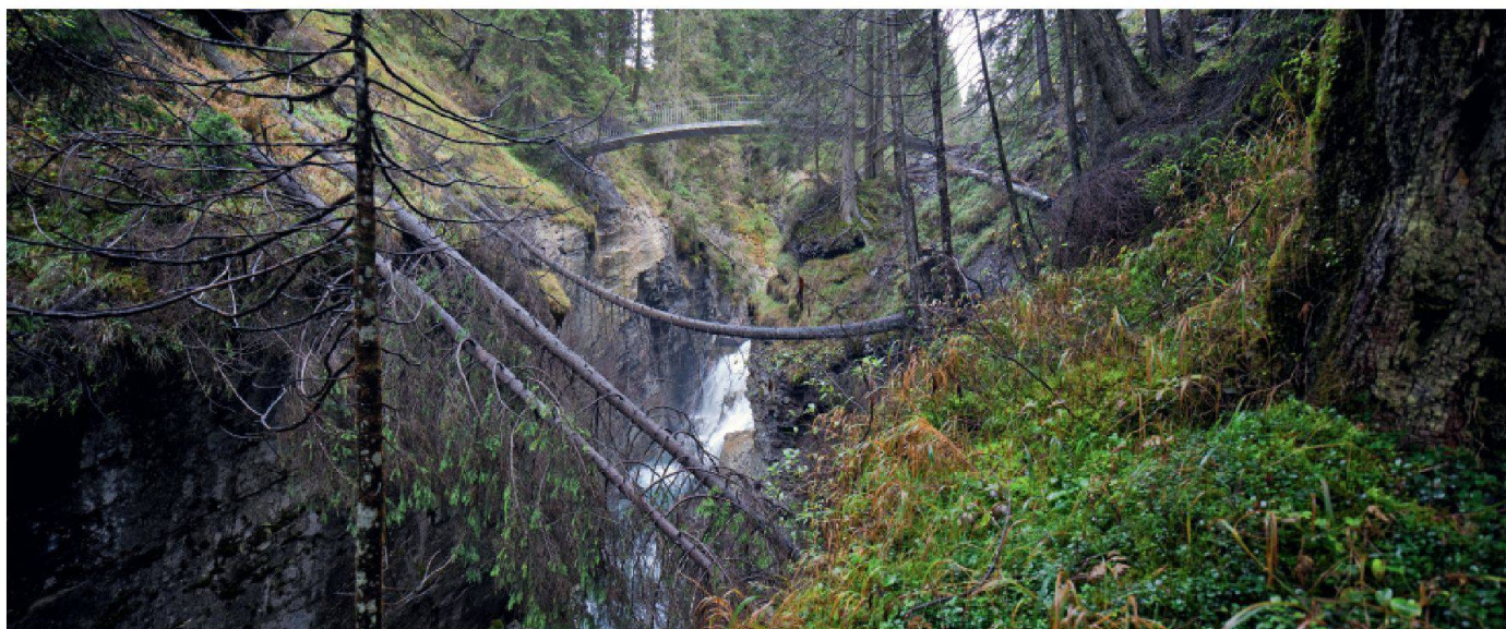
Wasserfallbrücke: Das Extravagante der Konstruktion entstand aus schierer Notwendigkeit. (Foto: Wilfried Dechau)
