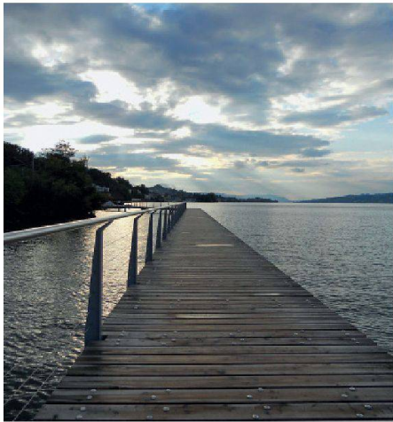
Der neue Seeuferweg zwischen Wädenswil Giessen und Richterswil wurde im Mai 2013 eröffnet. (Foto: Lukas Denzler)
