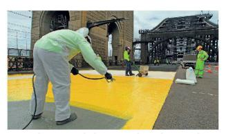
Korrosion kann grosse Schäden an tragenden Strukturen anrichten. Waterproofing-Technologien von Sika liefern effektiven und andauernden Schutz. Sie wurden speziell entwickelt für eine effiziente Durchführung von Erneuerungsarbeiten.
