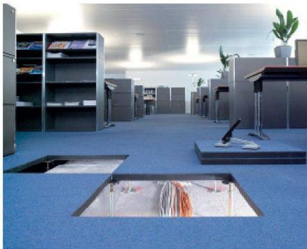
Bürogebäude unterliegen mehr denn je einem Wandel in der Flächennutzung und der Raumstruktur. Mit den wachsenden Ansprüchen an Energieversorgung und Datentransfer stehen bei Konstruktion und Bewirtschaftung von Büroflächen auch Systemböden wie Doppel- und Hohlböden im Fokus.
