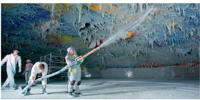
06 Die fünf Entstehungsphasen des Reliefs. Phase 1 (September 2007-Februar 2008): Anbringen des Trägermaterials (Epoxidharz) für die Stalaktiten und der verformten Aluminiumplatten für Höhlen und Wellenstrukturen.
