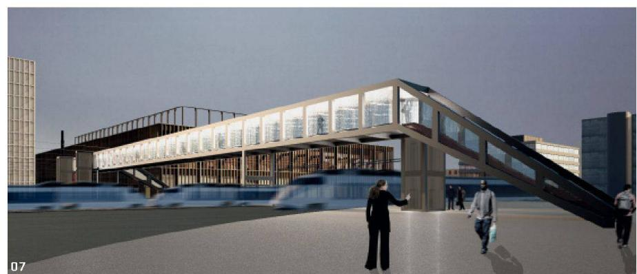
**01–03** Zur Weiterbearbeitung und Realisierung empfohlen: Bei der dreifeldrigen Fachwerkbrücke «Malaparte» mit V-förmigen Stützen ist ein Stützenausfall statisch zulässig, ohne dass die Brücke einstürzt. (Bild: Synaxis mit Michael Meier und Marius Hug Architekten)
