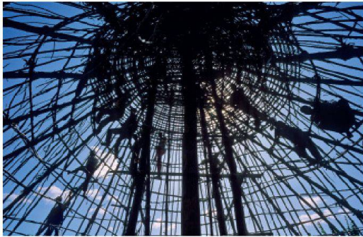
Handwerker konstruieren das Dach eines traditionellen Rundhauses im ländlichen Äthiopien. (Foto: Keystone/Photonon-stop/Bruno Barbier)
