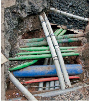
Bevor in die Tiefe gebaut werden kann, ist der genaue Verlauf zahlreicher Werkleitungen abzuklären. (Foto: istockphoto.com)
