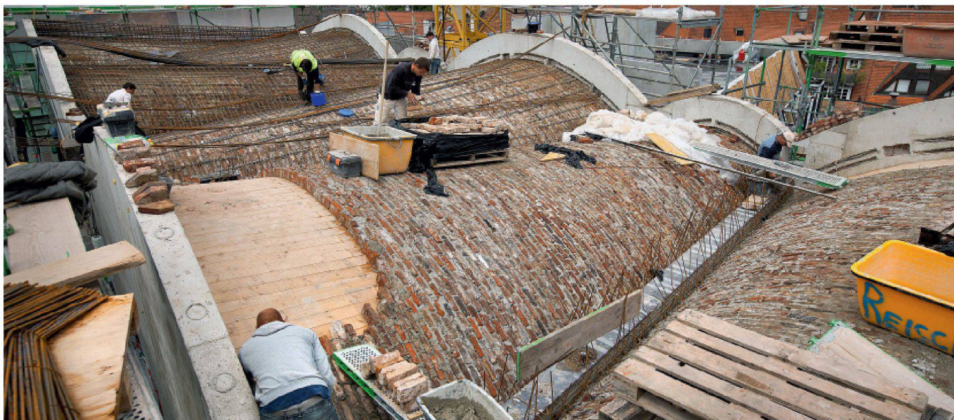
01 Unter der geschwungenen Dachkonstruktion verbirgt sich ein selbsttragendes Tonnengewölbe. (Foto: Ernst Fessler)
