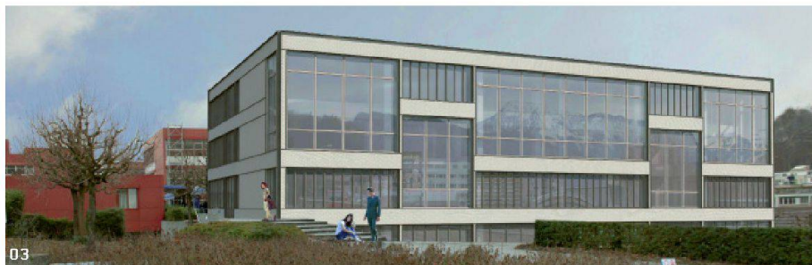
03–04 «Neuer Raum für die interdisziplinäre Lehre»: Das Projekt entwickelt eine unspektakuläre Ertüchtigung eines Gebäudes auf dem Hochschulcampus Horw. Der Bau wird durch eine längsseitig vorgestellte Raumschicht vergrössert. Ein Grossteil der Substanz wird weiterverwendet, die strenge Stützenstruktur durch neue Wände freigespielt und durch zweigeschossige Raumzonen geöffnet.
