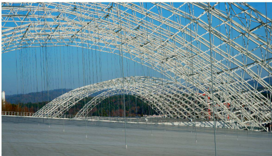
01 Weit gespannte Stahlbau-Fachwerkbögen: Sondermülldeponie SMDK, Källiken. Totalunternehmer: ARGE SMDK Infra (Marti/Züblin); Stahlbauplanung: Züblin Stuttgart. (Foto: SMDK Källiken)
