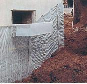
**DELTA®-DRAIN**Bauwerksdrainage nach DIN 4095 und Grundmauerschutz
