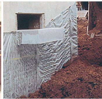
DELTA®-DRAIN Bauwerksdrainage nach DIN 4095 und Grundmauerschutz
