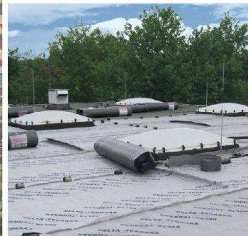
DELTA®-TERRAXX Schutz- und Drainagesystem für druckbelastbare Untergründe
