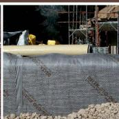
**DELTA®-GEO-DRAIN Quattro**Vierlagiges Schutz- und Drainagesystem für Dickbeschichtungen
