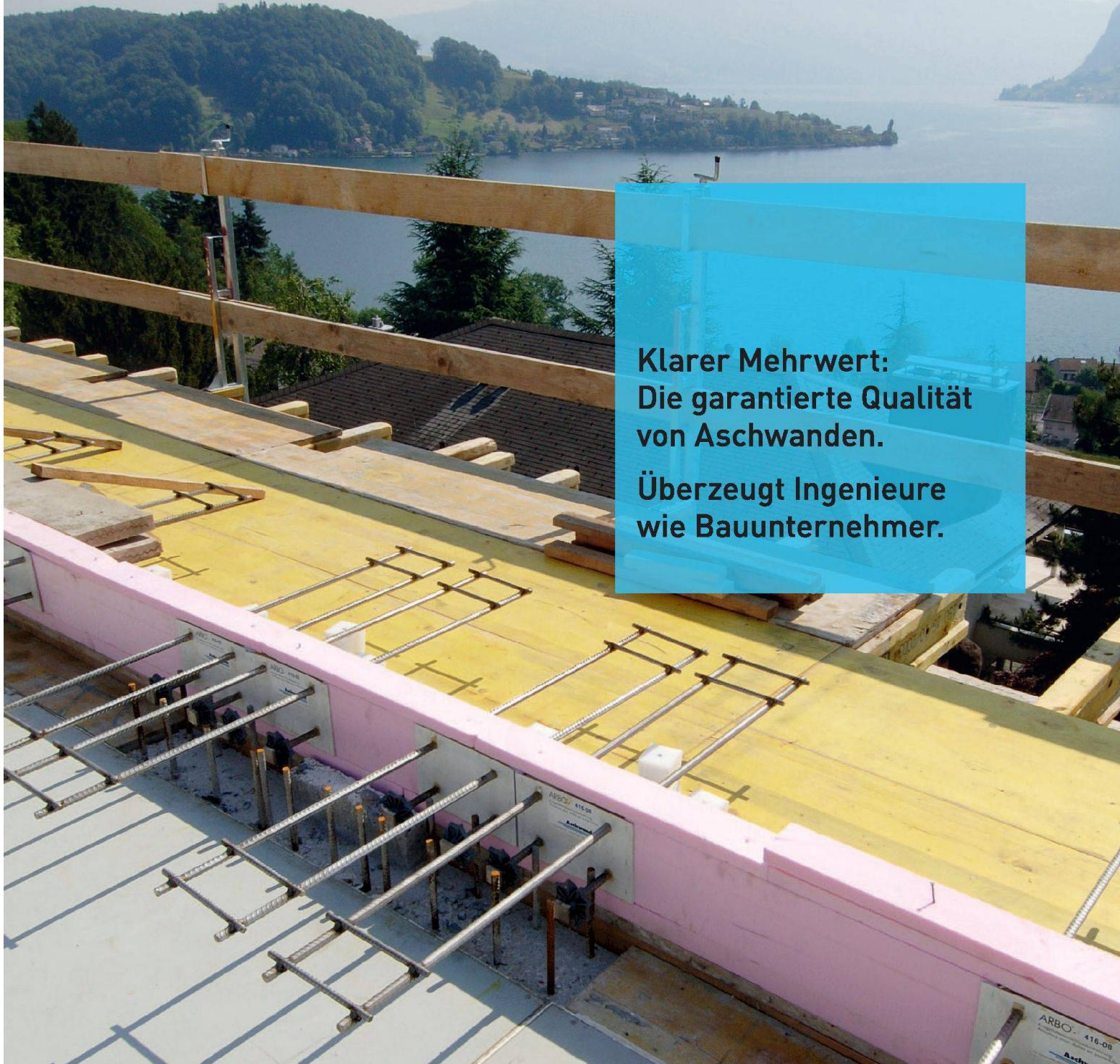
Zum Beispiel ARBO, das umfassende Sortiment an Bewehrungselementen zur Wärmedämmung: Sicherheit und Qualität gewährleistet Aschwanden mit normenbasierten Systemen. Sie sind für die Bewehrung und Kraftübertragung im Stahlbetonbau unübertroffen. Unsere Produkte werden nach strengsten Standards von Spezialisten und Hochschulkapazitäten entwickelt und von der EMPA geprüft.
