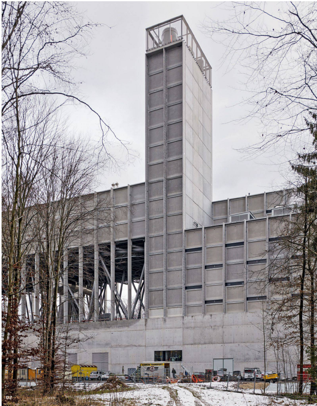
01 Querschnitt Kaminurm und Prozessgebäude. (Pläne: Graber Pulver Architekten) 02 Fernwärmezentrale mit Raumfachwerk links, Kamin in der Mitte und Prozessgebäude mit modularer Fassade rechts: Das Kamin-Faltwerk bildet eine vertikal vorgespannte Wabe aus vorfabrizierten Elementen. Kernstück bilden geschosshohe Raumelemente des 70 m hohen Treppenhauses. (Foto: Georg Aerni)
