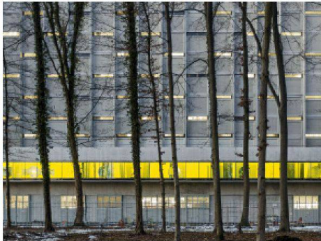
Der beleuchtete Besucherkorridor zeichnet sich als gelbes Band zwischen Ortbetonsockel unten und modularer Fassade oben ab. Er bildet eine öffentlich zugängliche Schnittstelle zwischen Stadt und Technik. (Foto: Georg Aerni)
