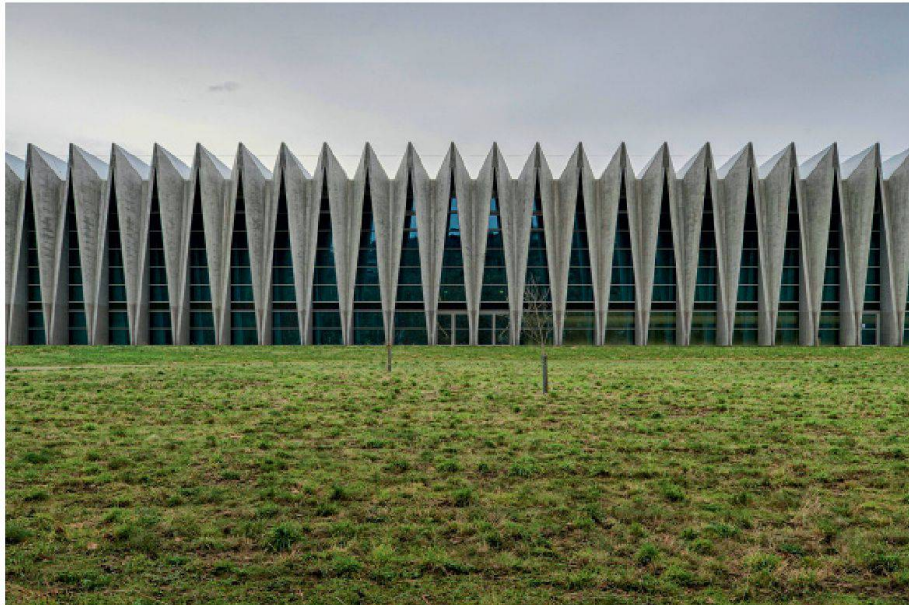
01 Feingliedriges Falwerk: Sportausbildungszentrum Mülimatt, Brugg. Tragwerksplanung: Fürst Laffranchi Bauingenieure GmbH, Wolfwil; Architektur: Studio Vacchini Architetti, Locarno. (Foto: Christian Beutler/NZZ)
