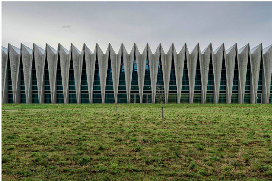
01 Feingliedriges Faltwerk: Sportausbildungszentrum Mülimatt, Brugg. Tragwerksplanung: Fürst Laffranchi Bauingenieure GmbH, Wolfwil; Architektur: Studio Vacchini Architeti, Locarno. (Foto: Christian Beutler/NZZ)
