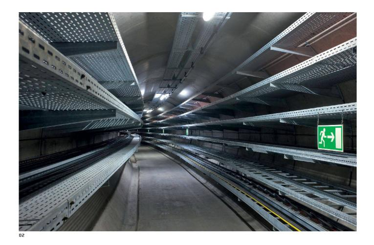
02–03 Zwei vorgängig erstellte Werkleitungsstollen unter dem Reussportbeziehungsweise über dem Sonnenbergtunnel stellen die redundante Verkabelung der Betriebs- und Sicherheitsausrüstungen sicher. (Foto: Priska Ketterer, Luzern; Grafik: Astra)
