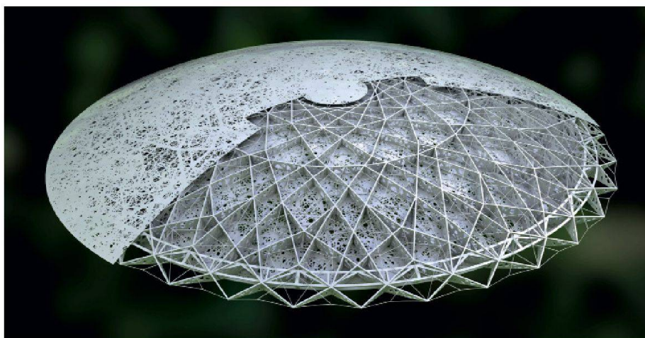
01 Die Perforationen in der Kuppel des Louvre International in Abu Dhabi (Durchmesser 180 m, Stichhöhe 25 m) sorgen für variable Belichtung im Innern. (Rendering: Atelier Jean Nouvel AJN, Paris)
