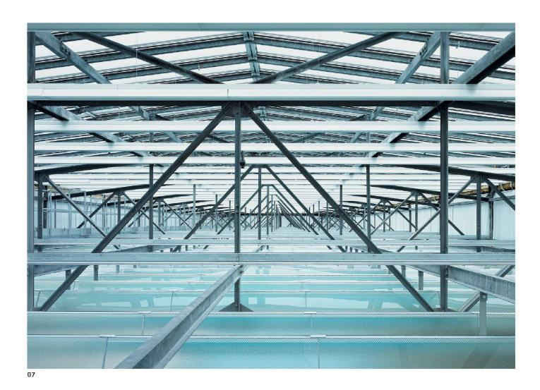
07 Blick in den Dachraum mit erhaltener Stahlkonstruktion, neuem Oberlicht aus Glas-
