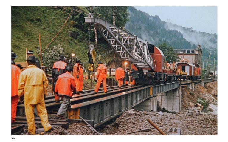
01 Kurzfristiger Einbau einer Hilfsbrückenkette auf Betonpfeilern an der Gotthard-Nordrampe bei Gurtnellen, nachdem das Hochwasser vom 24./25. August 1987 das Bahntrassee unter-
