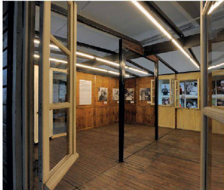
01 «Maisons démontables» als Ausstellungsträger: Aus Stahlrahmen mit eingeschobenen Bretterwänden konstruierte Pavillons für Geschädigte des 2. Weltkriegs in Frankreich (Foto: Schweizerisches Landesmuseum)
