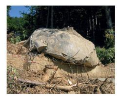
01 Durch einen Erdrutsch zerstörtes Wasserreservoir (Foto: Hetzer, Jäckli und Partner AG)
