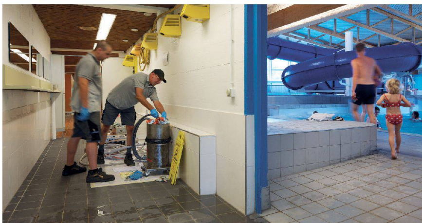
Rohrrinnensanierung mit HAT-System: Keine Baustelle. Kein Aufreissen. Kein Bauschutt. Kein Lärm. Also auch keine Betriebsunterbrechungen.
