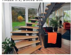
Am Stand der Firma Keller ist unter anderem eine Treppe mit herauskragenden Stufen aus gebürstetem und geöltem Lärchenholz, mit Handlauf aus Lärche und Edelstahlgeländer zu sehen. Weiter ist die «Oeko-Trend», eine freitragende Treppe aus parkettverleimtem Buchenholz mit Edelstahlsprossen ausgestellt. «Loft» ist eine Treppe, die in jede modern gestaltete Umgebung passt. Die Wangen sind aus Vollkernplatten, die Stufen sowie der Handlauf aus geöltem amerikanischem Kirschbaumholz.
